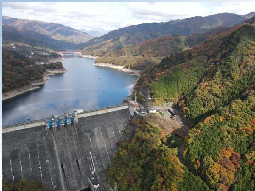
↑ 上空から撮影した草木ダム
